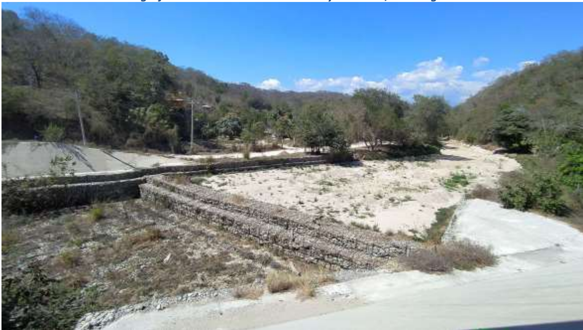
Fotografía 29. Presa de Gavión en Arroyo Chahué, la más grande
