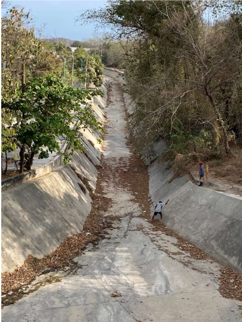
Fotografía 8. Canal del río Chahue
