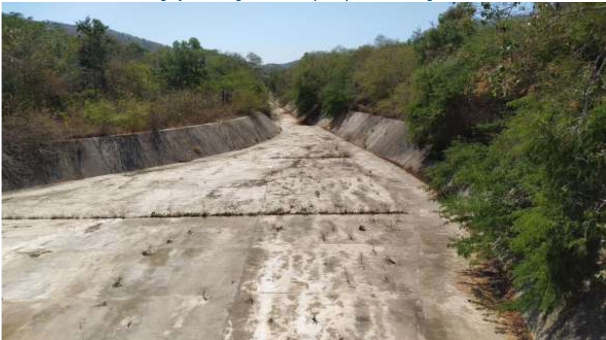
Fotografía 27. Origen del canal principal del río Tangolunda
