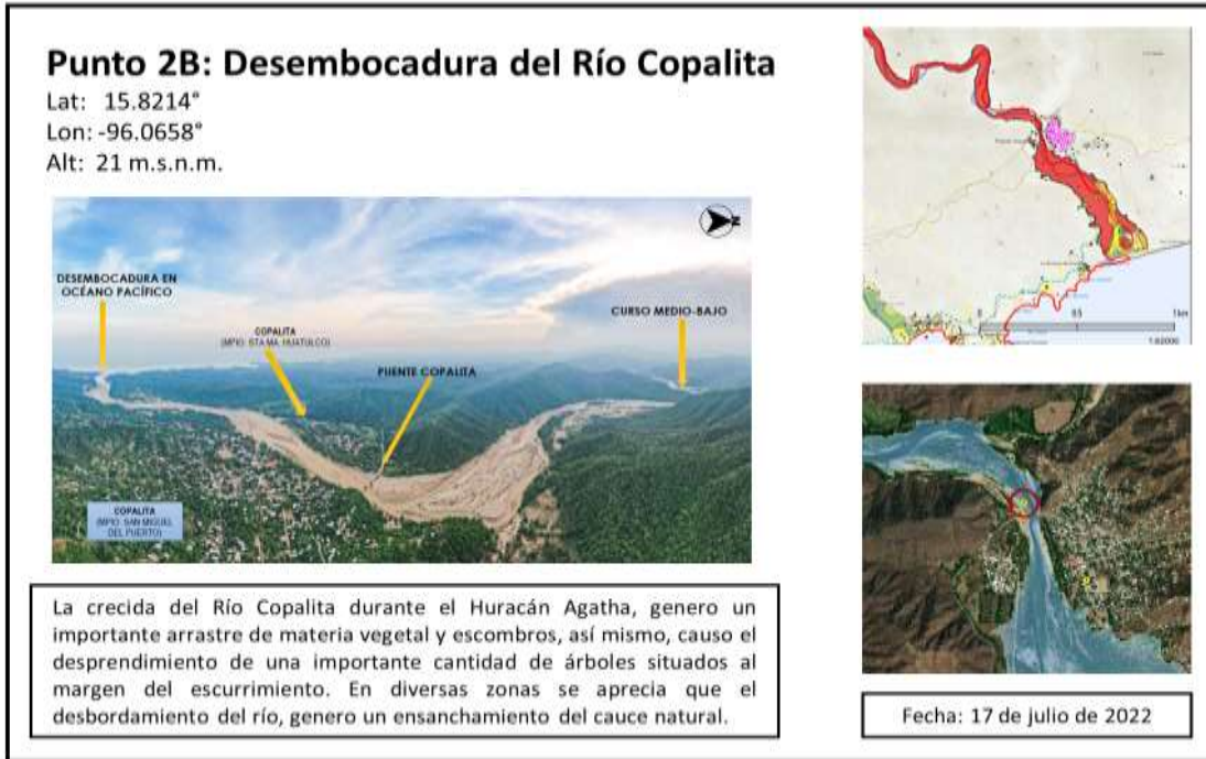
Figura 11. Descripción de zonas de afectación durante el Huracán Agatha (2022). Punto 2B: Desembocadura del Río Copalita
